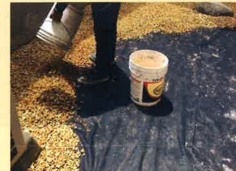
景石のみを残し、防草シートを全面に敷いた上で砂利を敷き詰めます。
