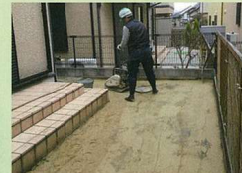
土をすき取り、整地
