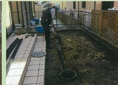
地中の水路 暗渠管(あんきょかん)を布設
