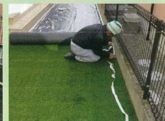
人工芝を敷設
