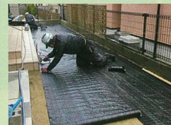
防草シート敷設作業
